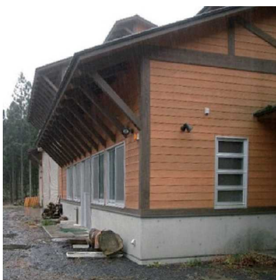
基礎が高く軒の出が大きい建築物
